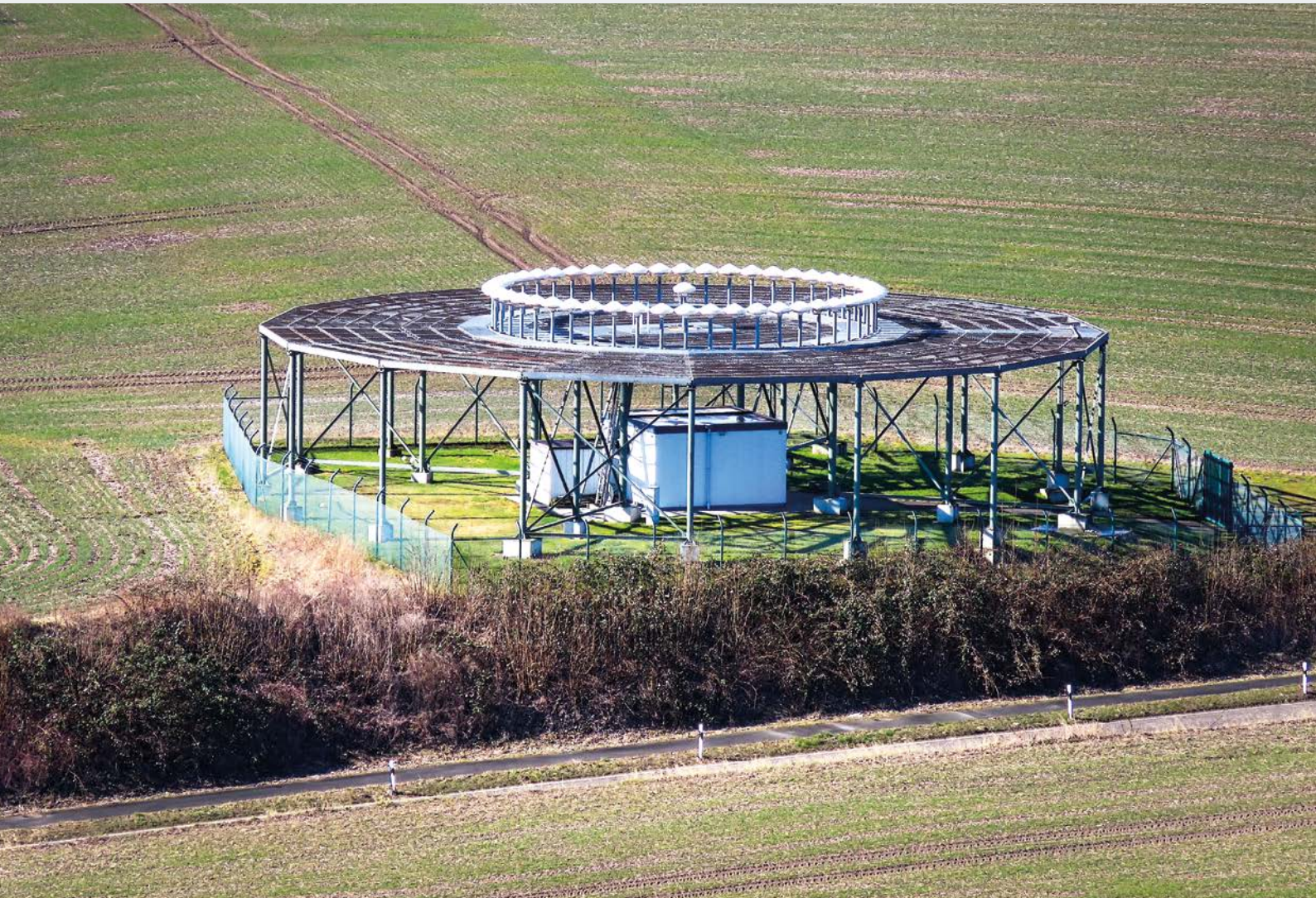
Die DFS kann nach entsprechender Überprüfung den Anlagenschutzbereich ihrer DVOR-Anlagen überprüfen und ggf. verringern. Foto: Fabian Horst/Wikimedia CC by s.a.4.0
